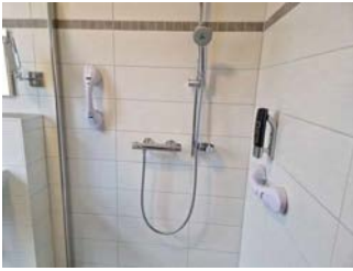
Haltegriffe in der Dusche
