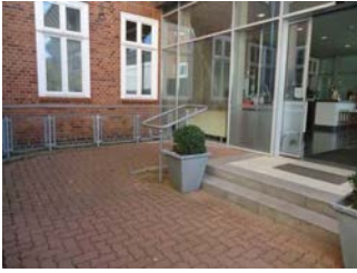
Rampe zum Eingang in das Hotel mit Handläufen
