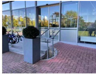
Rampe am Eingang
